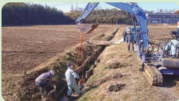
排水路柵渠板補修
