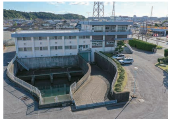
船戸揚水機場（水資源機構・北総管理所）
