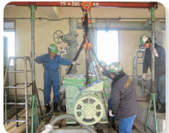
加圧機場ポンプ整備工事
