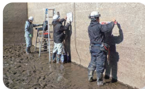
返田揚水機場中継水槽壁面調査
