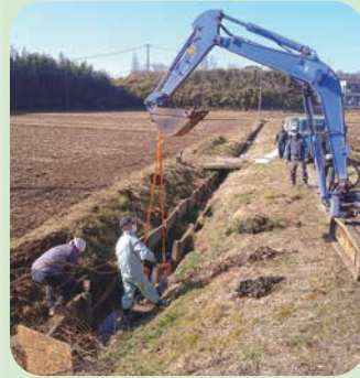
水路柵渠板補修
