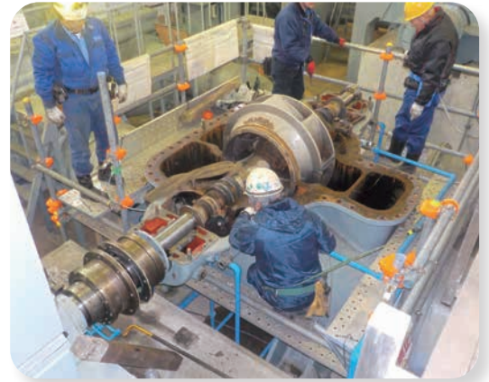
返田揚水機場ポンプ整備工事
