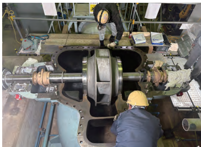
返田機場 NO3 ポンプ分解整備工事
