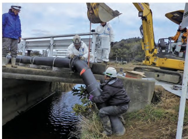
水管橋補修工事(中沢工区)
