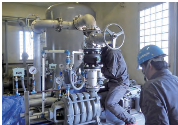
加圧機場ポンプ設備整備工事
