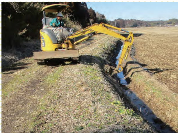
水路の掘削・泥上
