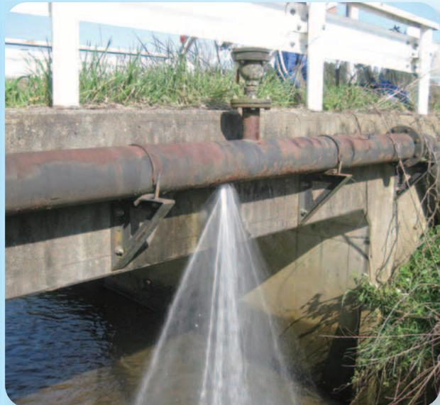
水管橋腐食による漏水
